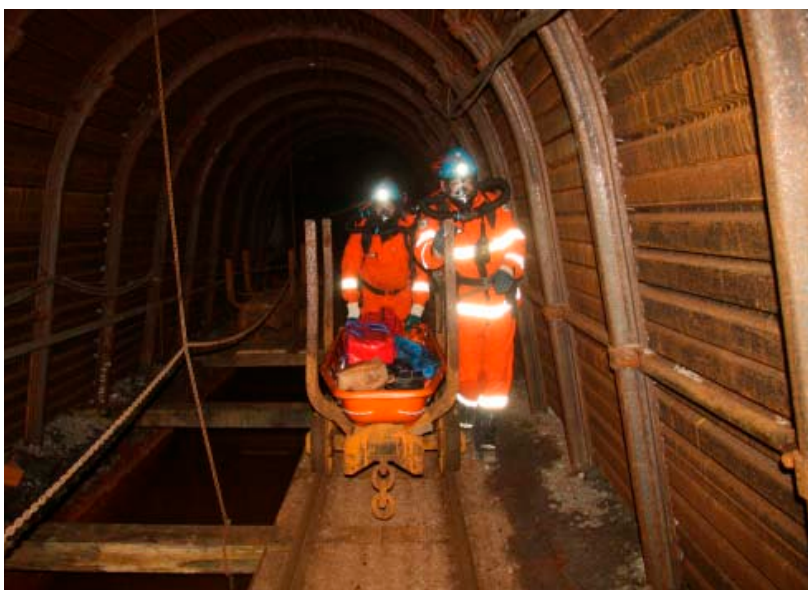
V letitých štolách se setkáte s unikajícími plyny, ale ohrožují vás také degradující výztuže
